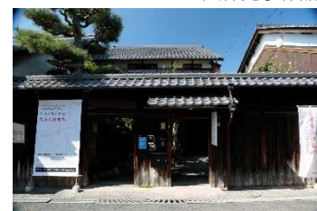
ボーダレス・アートミュージアム NO-MA 外観
